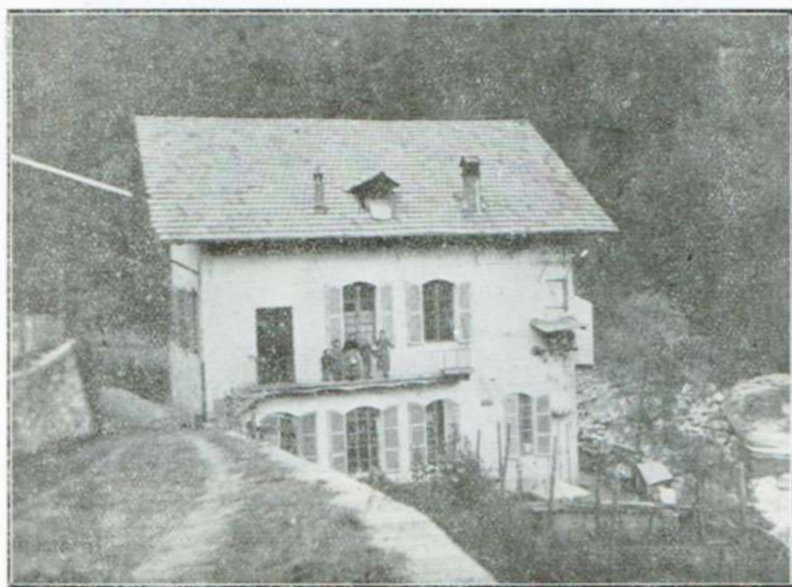
Centrale Idroelettrica Valsessera in regione Cavallero
