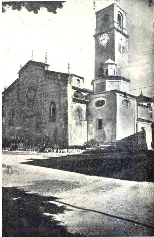
Facciata occidentale ed esterno della Cappella di S. Giulio
