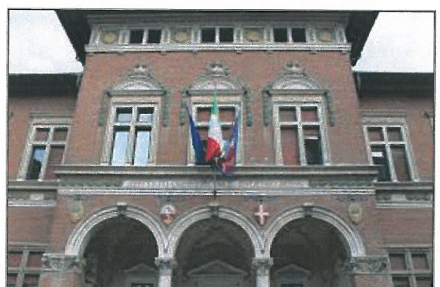
Fig. 46 Facciata dell'Istituto Commerciale E. Bona
