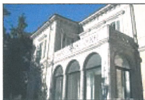
Villa Schneider esterno
